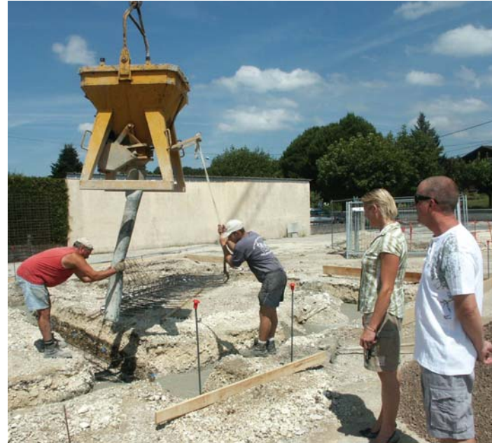
Le Maire Nathalie Johnson et son Adjoint Pascal Bally sur le chantier.
