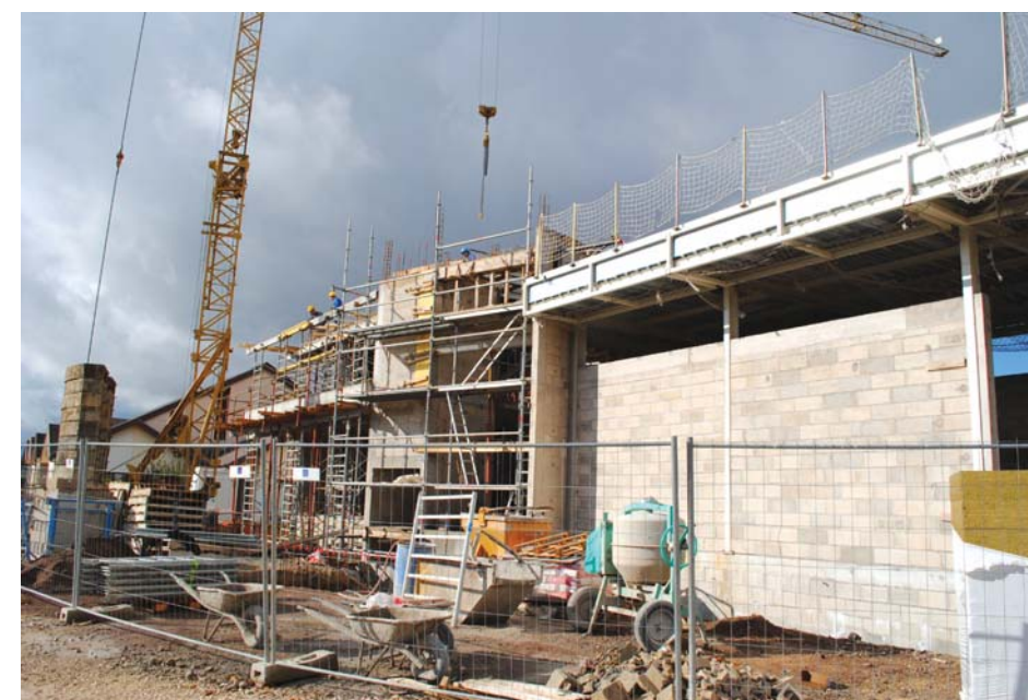
Les travaux de la nouvelle Mairie avancent à grand pas : l'essentiel du gros-œuvre devrait être terminé avant l'hiver.
