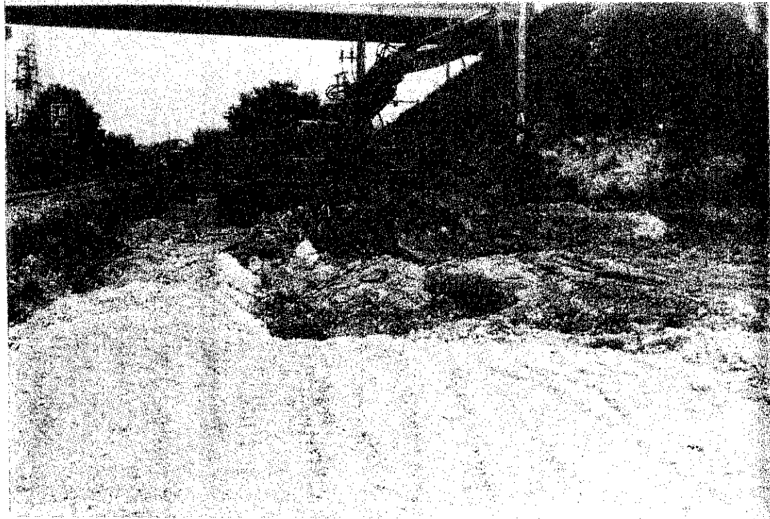
Avancement des travaux, rue des Sablières, le 28 JUIN 1981
