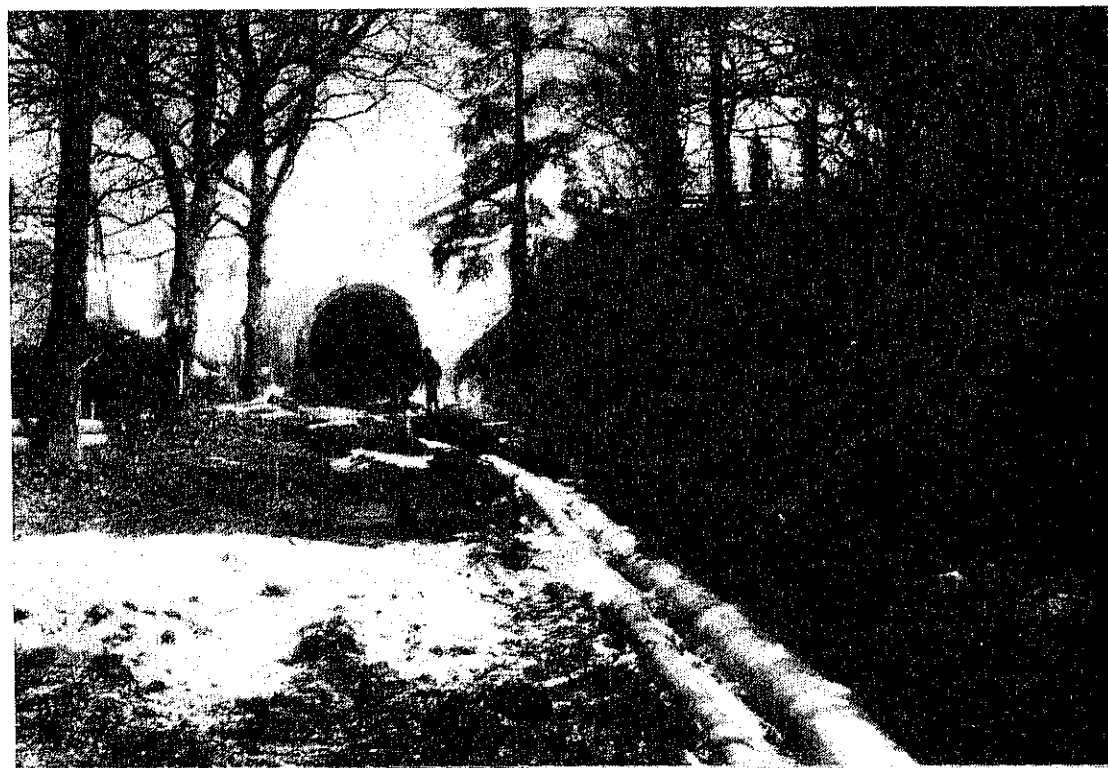
Rebouchage le 14 AVRIL 1982, au premier plan : l'assainissement
