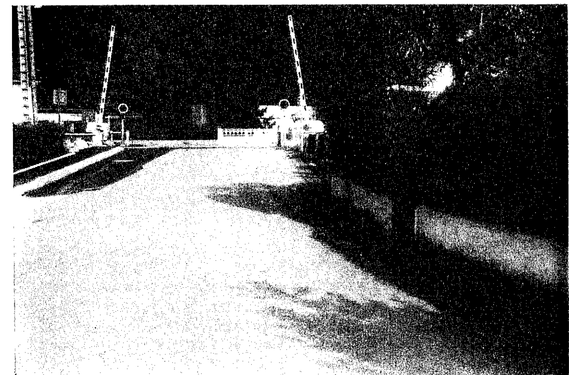
Vue des travaux terminés, le 3 OCTOBRE 1982
