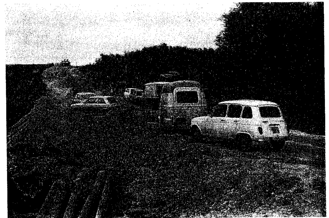
Ebauche de la voirie, fin SEPTEMBRE 1981
