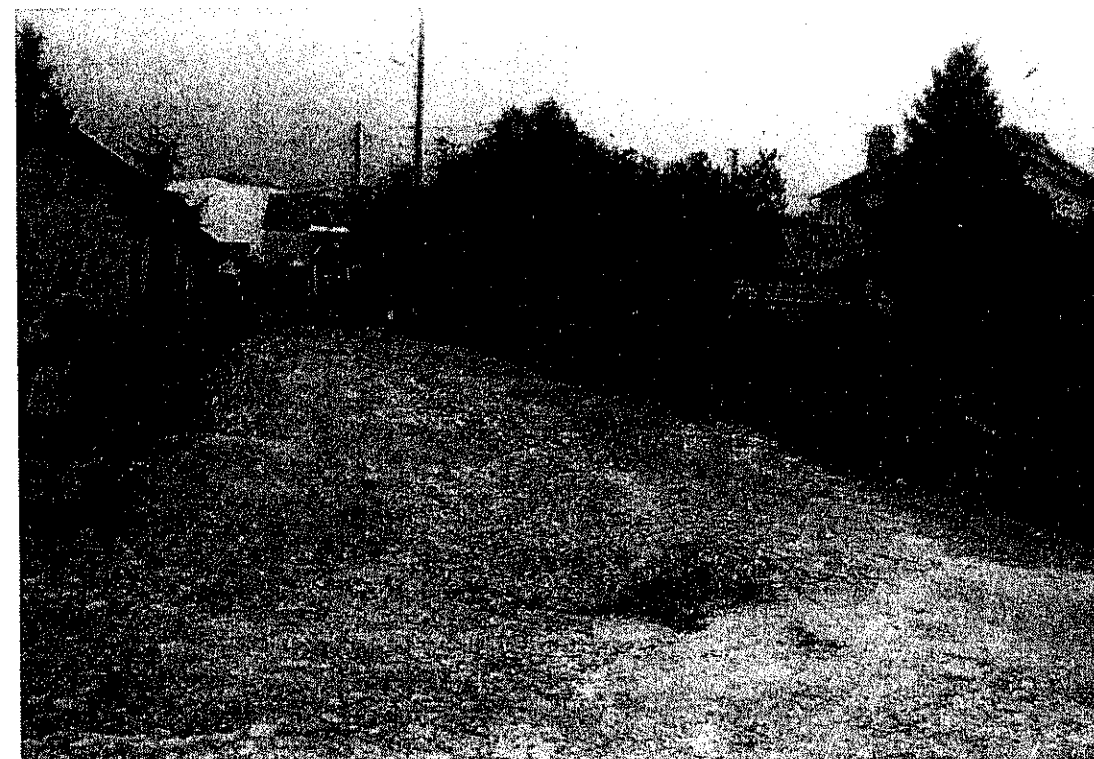
Travaux assainissement, voies intérieures, cités S.M.A. MAI 1981
