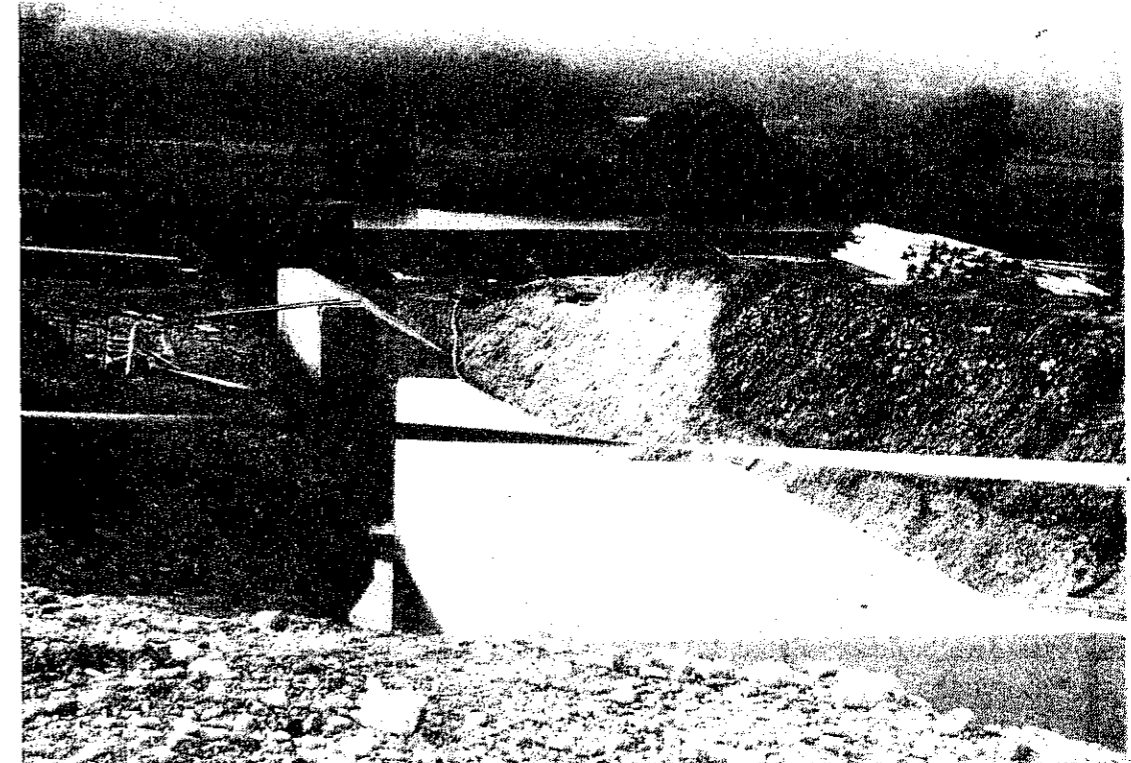
Même photo que la précédente, avec piliers coulés, Octobre 1979
