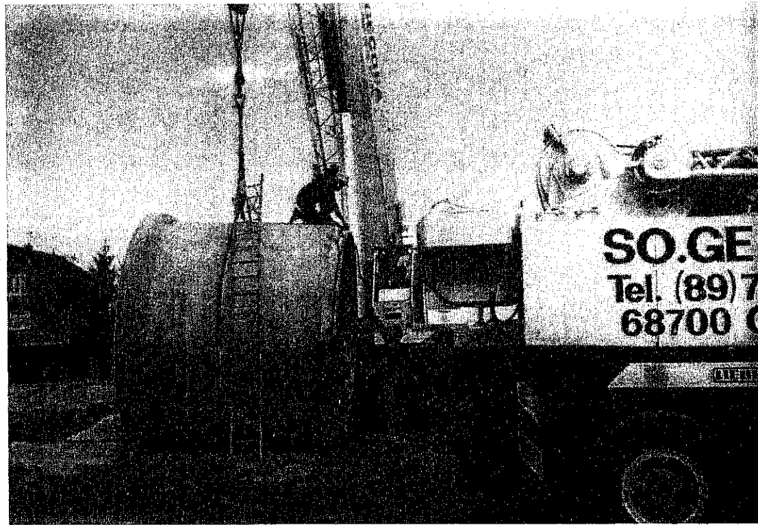
Arrimage du dernier tuyau, le 13 AVRIL 1982, à 16 H.40
